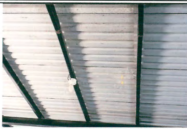
Foto 2: MEJORAMIENTO DE CUBIERTA DE LÁMINA DE AULA
