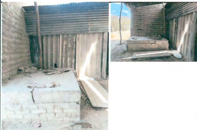
Foto 3: MEJORAMIENTO DE COCINA
