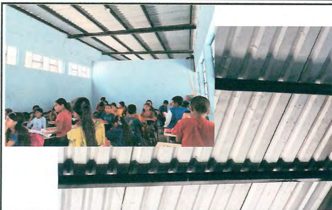
Foto 1: MEJORAMIENTO DE CUBIERTA DE LÁMINA DE AULA
