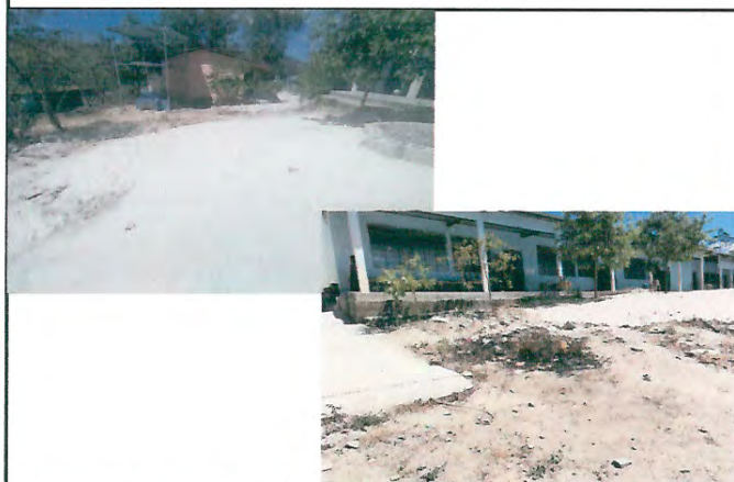
Foto 4: MEJORAMIENTO DE LOSA DE PATIO
